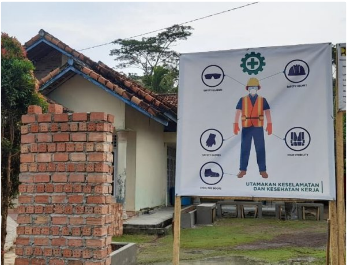
Proyek Infrastruktur Hunian Hijau di Mesuji
