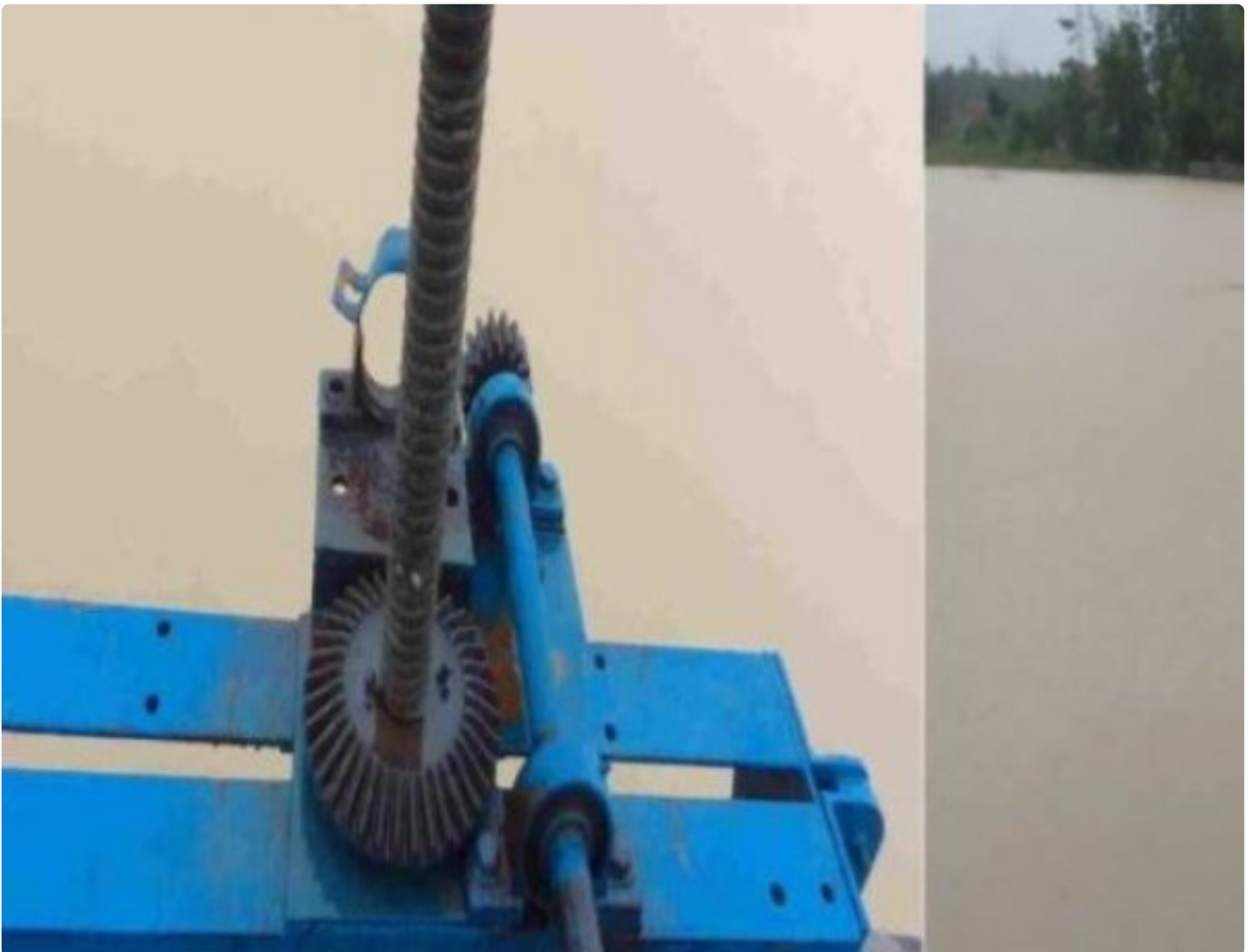
Pintu air Albaret Simpang Mesuji
